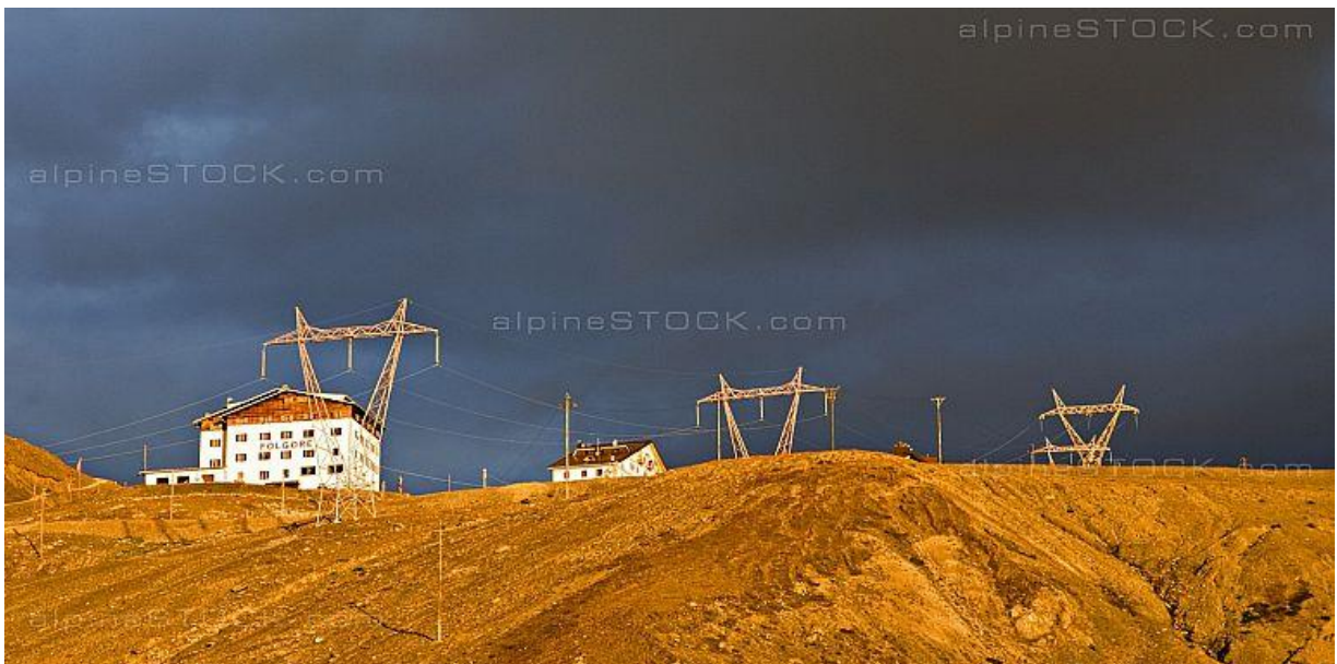
Hochspannungsleitung auf dem Stilfserjoch
